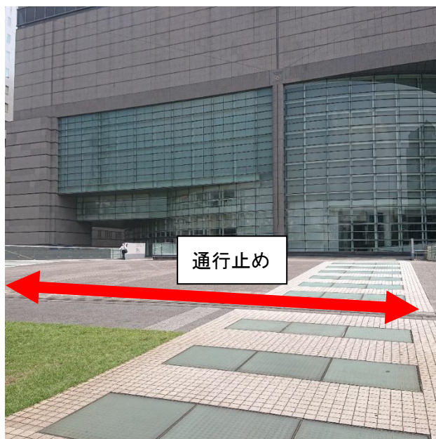
① 2階連絡橋は通行止めです。
